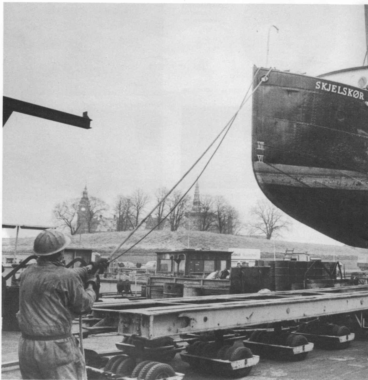
Flydekranen »Herkules« løfter 63 tons tunge »Skjelskør« på land.
